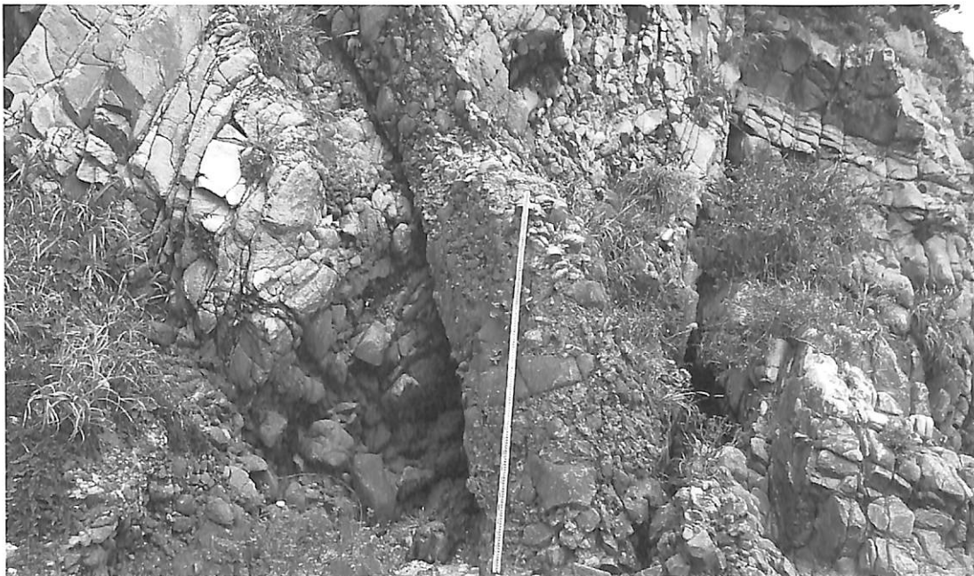
写真4 式根島大浦海岸西側の碎屑性岩脈（3m長の標尺部分）。撮影は2015年10月31日。
