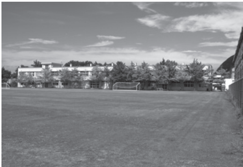
廃校となった旧新島中学校の全景。
