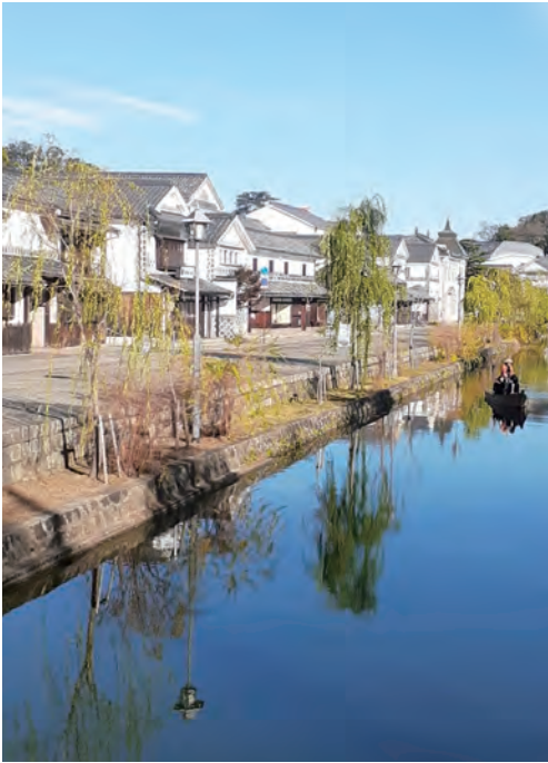
▲無電柱化と景観整備をセットで行った好例。自主視察した倉敷市美観地区にて
