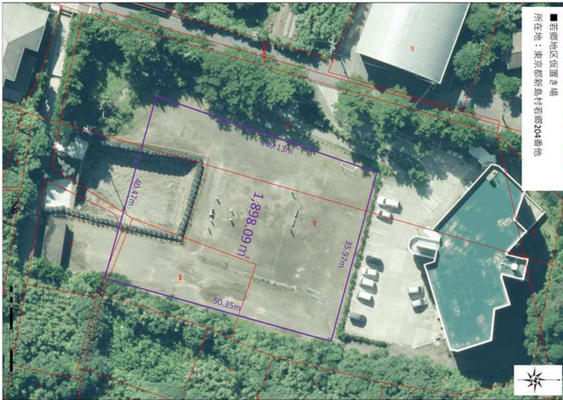
図 8.6 若郷地区の仮置き場の仮置き可能面積
