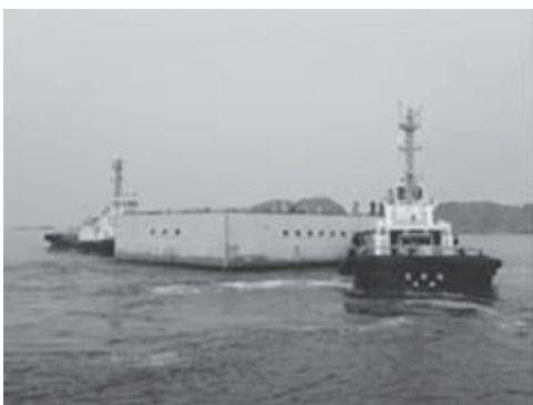
図①ケーソンを運搬している様子
