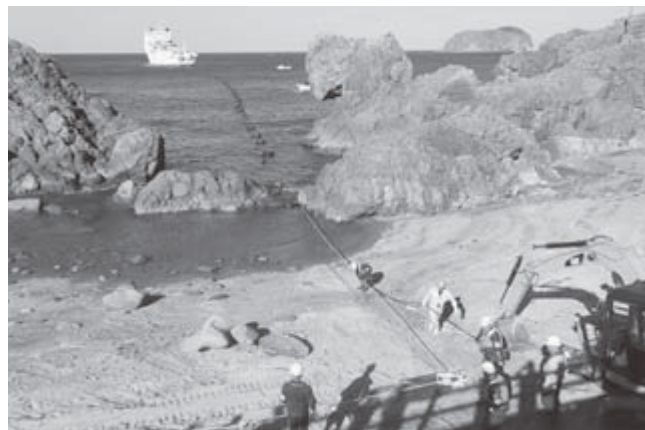
▲光の海底ケーブルの陸揚げ作業の様子
