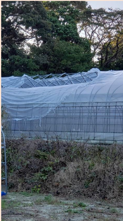
▲台風19号でのストロングハウスの被害
