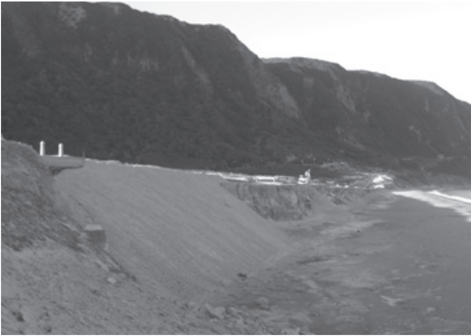
台風21号が残した爪痕—羽伏浦の護岸。
