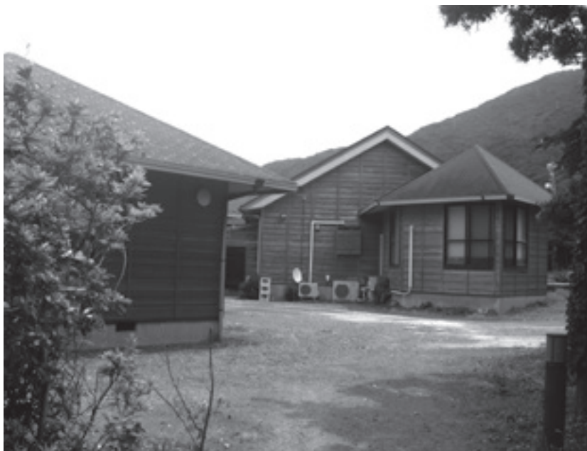
温泉ロッジの舞台裏。西側から見る。
