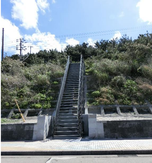
▲にしき乗り場前の津波避難路急勾配のため非常時の昇り専用。下りに使わないよう注意喚起/仕切りを検討予定
