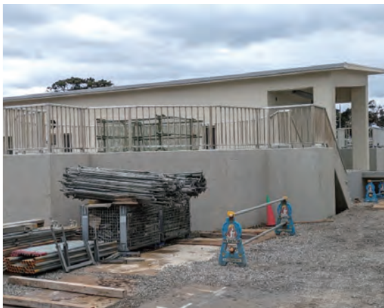
▲建設中の式根島下水道施設
