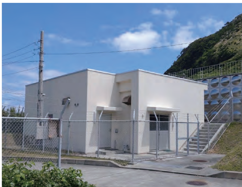
▲耐震化された若郷浄水施設
